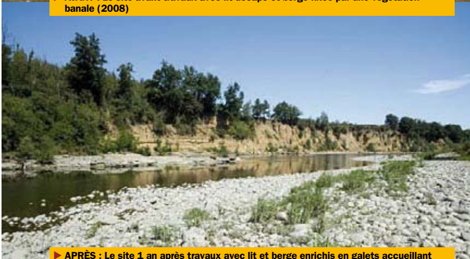
► APRÈS : Le site 1 an après travaux avec lit et berge enrichis en galets accueillant une végétation pionnière typique de Garonne (2009)
